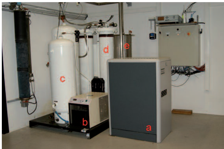
L'unité de production d'azote est composée d'un compresseur (a), d'un sécheur d'air (b), d'un réservoir d'air comprimé (c), de cuves de tamis moléculaires (d) et d'un réservoir d'eau pour l'humidification de l'azote (e). © M. Gunn
