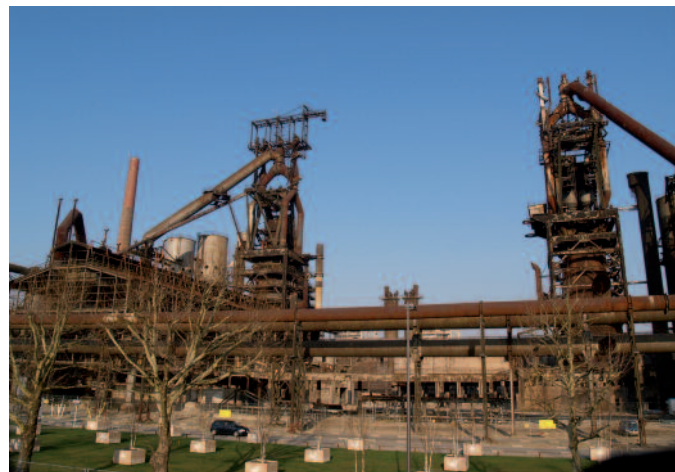
Les deux hauts fourneaux de Belval : état actuel © OCIM
